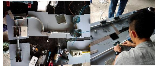
ภาพที่ 3 การเดินสายร้อยท่อ
